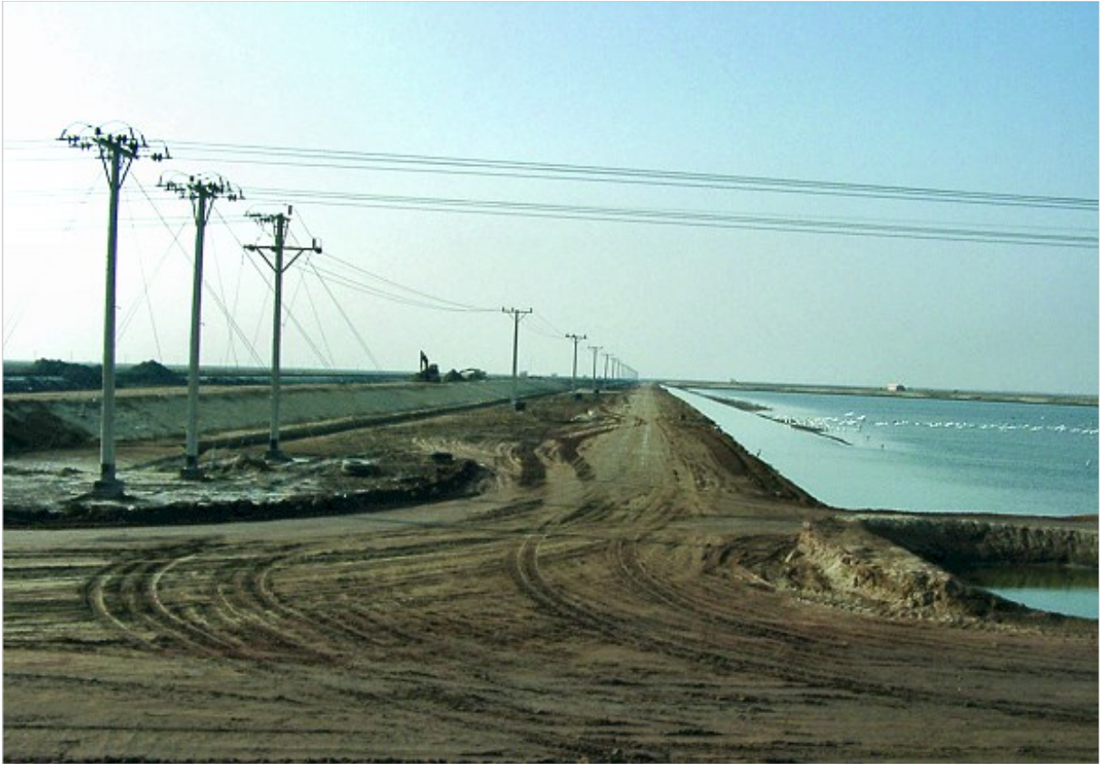
Abb. 5 - Baustelle in der Wüste
