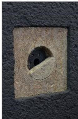
Abb. 4 - Capatect Natur+ Hanffaserdämmplatten werden auf die Außenwand geklebt und zusätzlich mit Tellerdübeln im Mauerwerk verankert. Sie lassen sich mit Systemprodukten von Caparol verputzen und wunschgemäß farbig gestalten.
