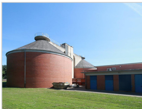
Abb. 2 - Kläranlage in Bad Oeynhausen Bild: www.energieagentur.nrw.de
