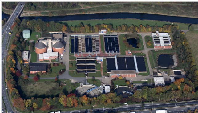
Abb. 1 - Kläranlage in Bad Oeynhausen Bild: www.energieagentur.nrw.de
