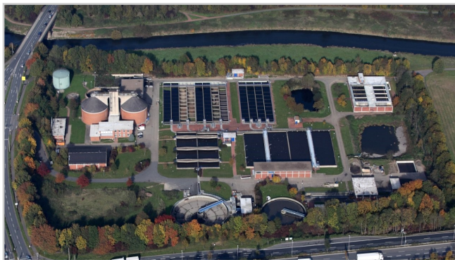
Abb. 1 - Kläranlage in Bad Oeynhausen Bild: www.energieagentur.nrw.de
