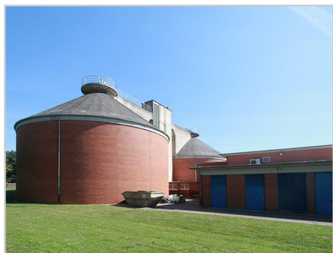
Abb. 2 - Kläranlage in Bad Oeynhausen Bild: www.energieagentur.nrw.de
