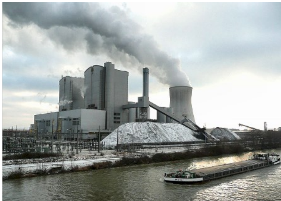
Abb. 2 - Kraftwerk in Hannover
