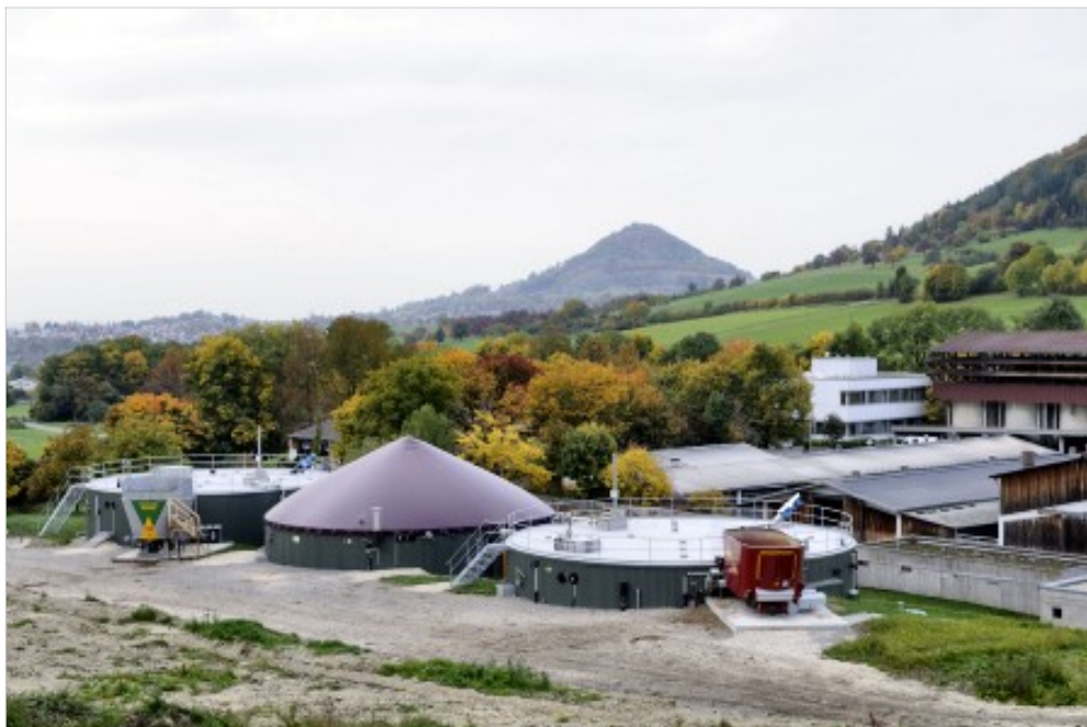
Abb. 1 - Biogasanlage UNI Hohenheim
