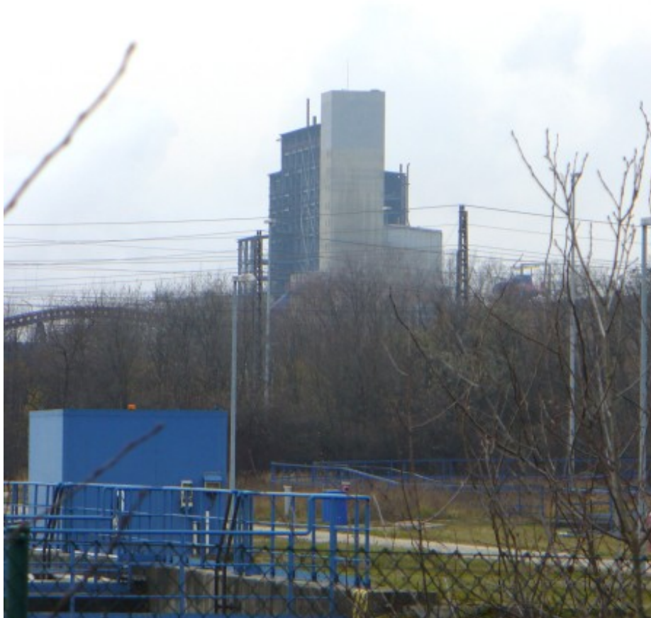
GSP-Vergaser in Schwarze Pumpe mit 200 MW (th), seit 1986 in Betrieb
