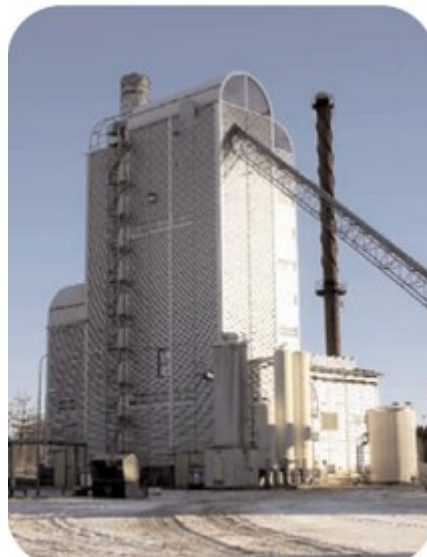
Växjö Värnamo Biomass Gasification Centre
