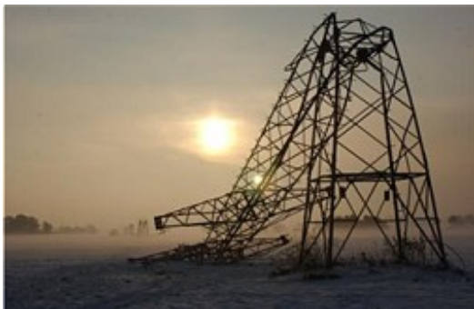
Mast- und Leitungsbruch durch Sturm
