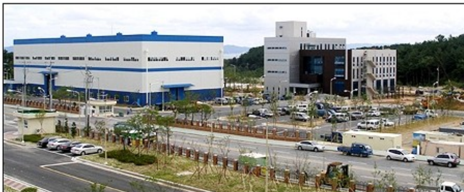
Das neue Brennstoffzellenanlagen-Werk in Pohang
